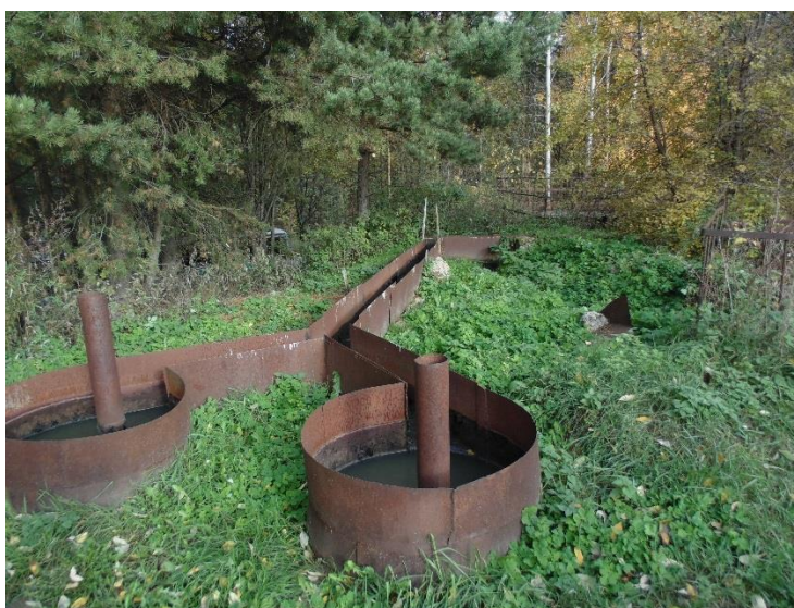
Рисунок 13 –Песколовки КОС п. ст. Громово
