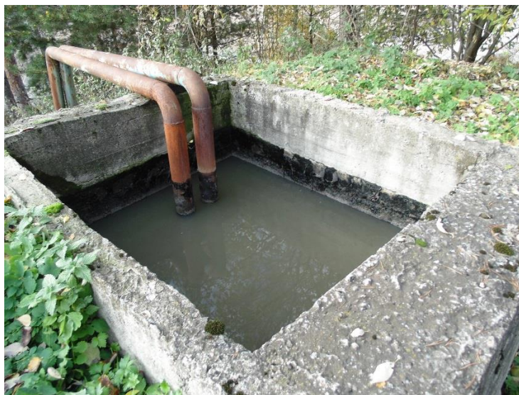
Рисунок 12 – Приемный резервуар КОС п. ст. Громово
