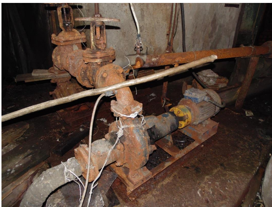
Рисунок 11 – Оборудование КОС п. Громово
