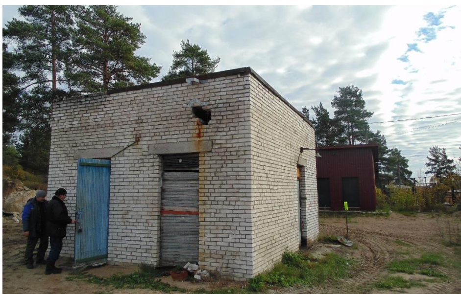
Рисунок 14 – Здание насосной станции п. ст. Громово
