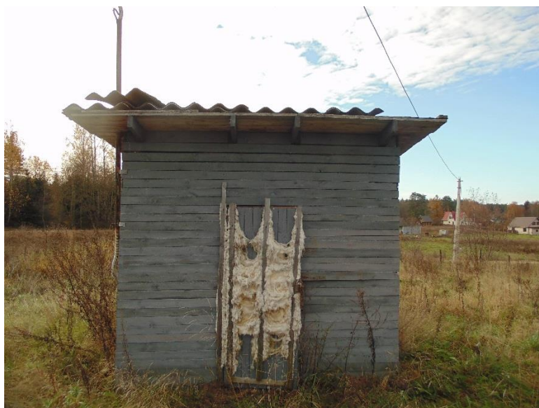
Рисунок 5 – Здание резервной скважины п. Громово
