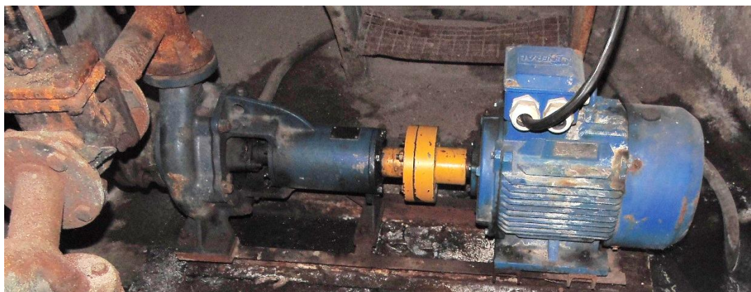
Рисунок 16 – Оборудование насосной станции п. ст. Громово
